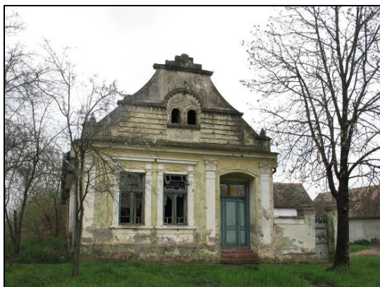
Kuća u ulici V. Nazora 19
